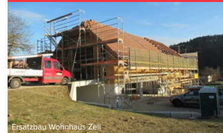
Ersatzbau Wohnhaus Zell
